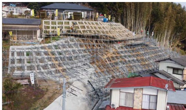
崩壊防止対策工事
