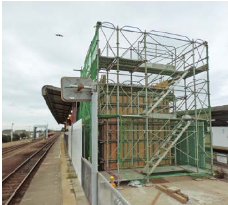
エレベーター設置工事の状況(大洗駅ホーム)
