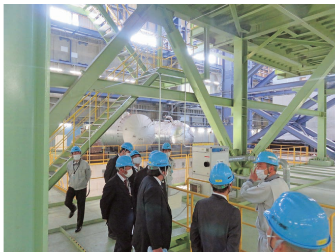
AtheNa（冷却系機器開発試験施設）内
